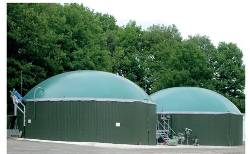
Tragluftdächer für Biogasanlagen
